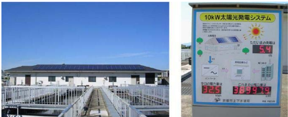
図 5.3 下水道処理施設への太陽光発電設備設置事例（京都府京都市鳥羽水環境保全センター）
