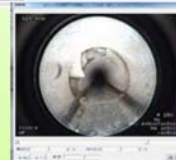
図 5.5 大阪府河内長野市における管路施設の包括的民間委託事例
