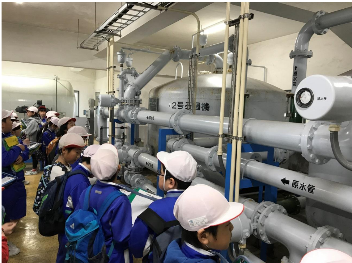
【ろ過機室で。井戸から汲み上げた水をろ過してから各家庭へ配水するまでを説明】
